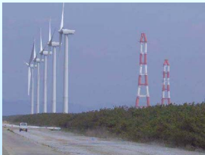
渥美風力発電所:風車の高さは99.9m、左の煙突は200m、右の煙突は150m
