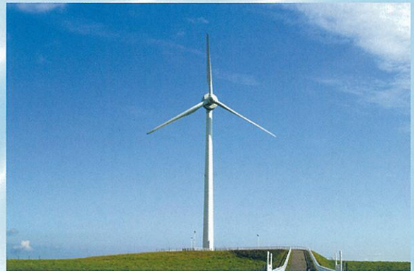
稲庭高原風力発電所(浄法寺町)
